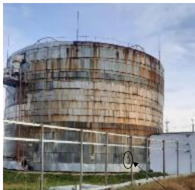
Рисунок 1 – Общий вид резервуара стального вертикального цилиндрического РВС-3000 и места нанесения заводского номера
