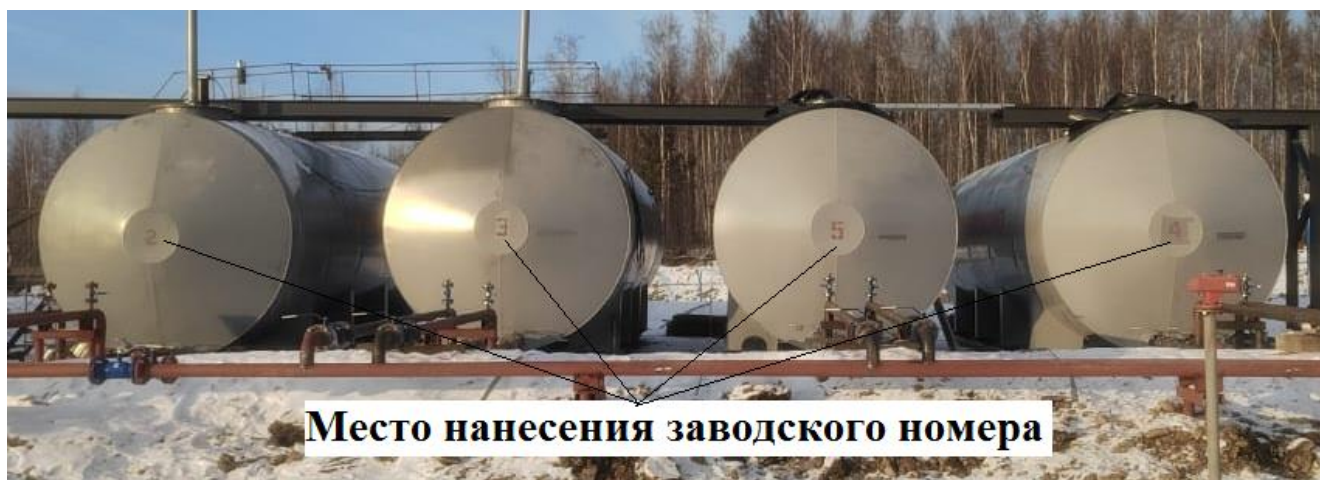
Рисунок 1 – Общий вид резервуаров горизонтальных стальных цилиндрических РГС-50 с указанием места нанесения заводских номеров
