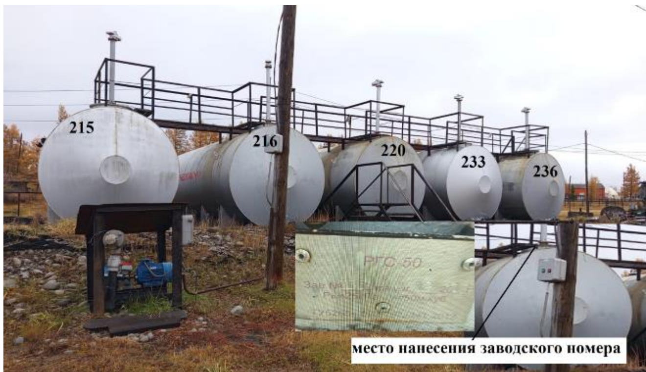
Рисунок 1 – Общий вид резервуаров горизонтальных стальных цилиндрических РГС-50 с указанием места нанесения заводских номеров
